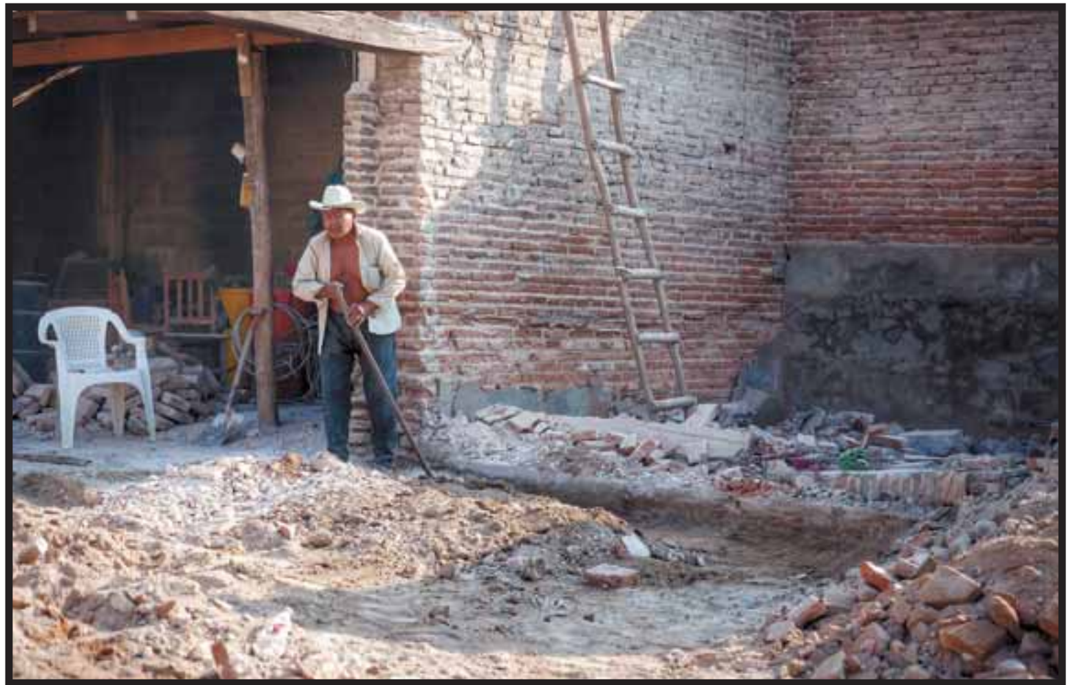
Un vecino de San Blas reconstruyendo su casa, que quedó derruida por el terremoto de septiembre de 2017.
